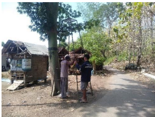
Gambar 8. Proses Pemasangan Penerangan Jalan Umum
