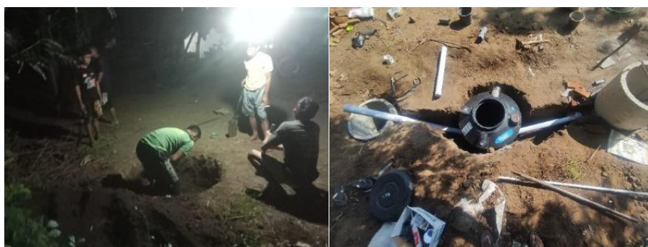
Gambar 6. Kegiatan Penggalian dan Pembuatan Digester
